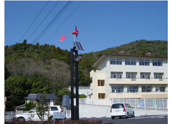
伊里認定こども園 発注者/備前市 ハイブリッド照明灯 フーライト HBS-TF-TR63
