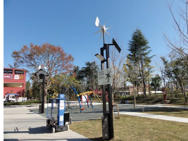
三井アウトレットパーク倉敷 ハイブリッド照明灯 フーライト HBS-TF-FM-CL63LL 3基
