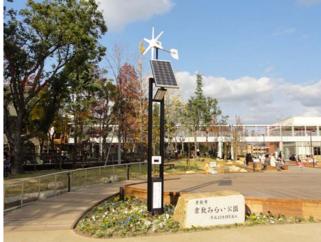
倉敷みらい公園 ハイブリッド照明灯 フーライト HBS-TF3-FM-SD-CL90特
