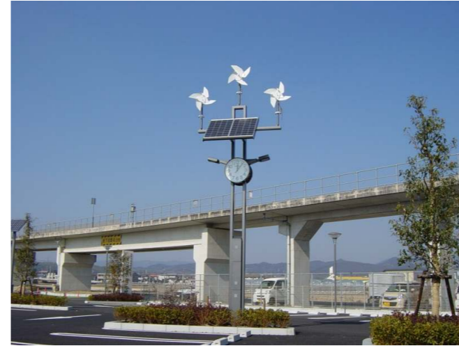
まびいきいきプラザ 発注者/倉敷市 ハイブリッド電源照明灯(時計付) HBS-TF5-P3-T-PL3W
