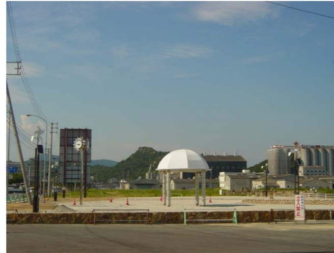
宇野港 港湾環境整備工事 発注者/岡山県備前県民局 ハイブリッド照明灯 フーライト HBS-TF-TR63 4基
